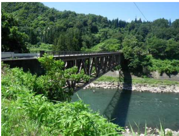
写真全景 (鋼橋)
