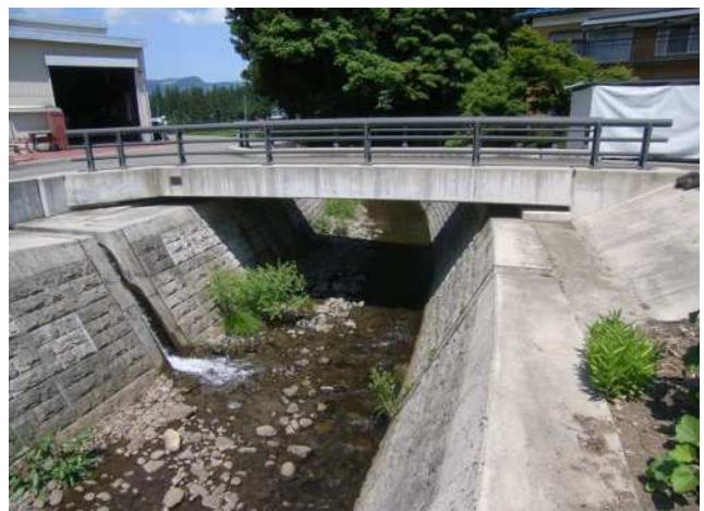
写真全景 (コンクリート橋)
